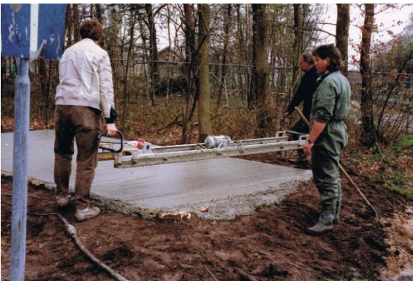
De grondplaat wordt gereed gemaakt
